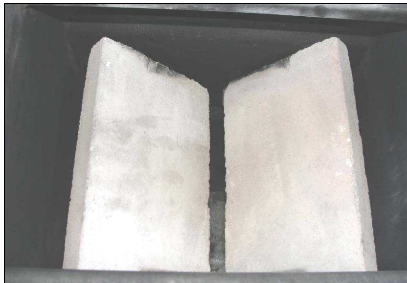
Фигура 5.4. Шамотни елементи са монтирани в пешната камера на котела серия "Pelletherm V.4 LT".
