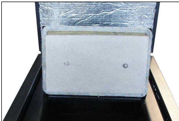
Фигура 5.11. Направляващите капаци на димоходния тракт на котела са поставени.
